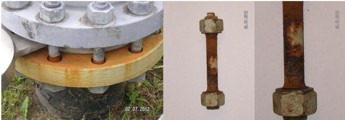
**Abb.4: Korrosionsproblem an waagerechten Flanschen in Außenanlagen**
