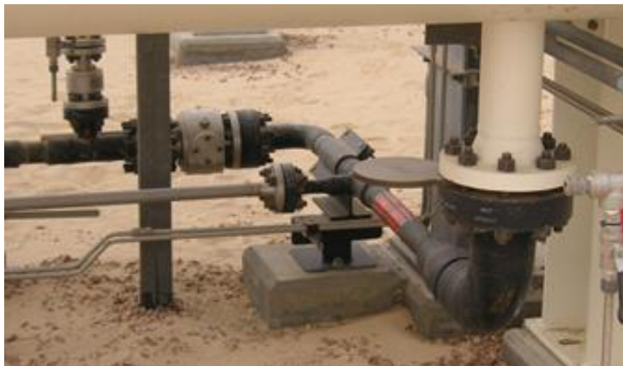
Abb.1: diverse Kunststoffflanschverbindungen (Quelle: Kundenfoto)
