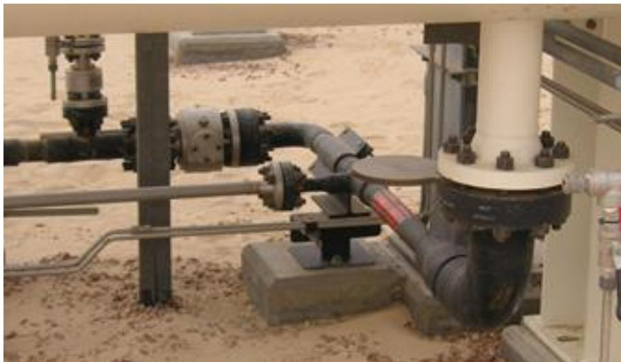
**Abb.1: diverse Kunststoffflanschverbindungen (Quelle: Kundenfoto)**
